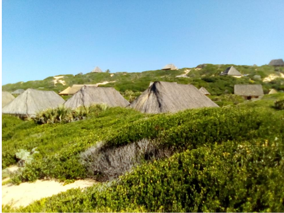
Foto 2: Vista parcial das infra-estruturas do projecto. Foto: KDSU (2022).
