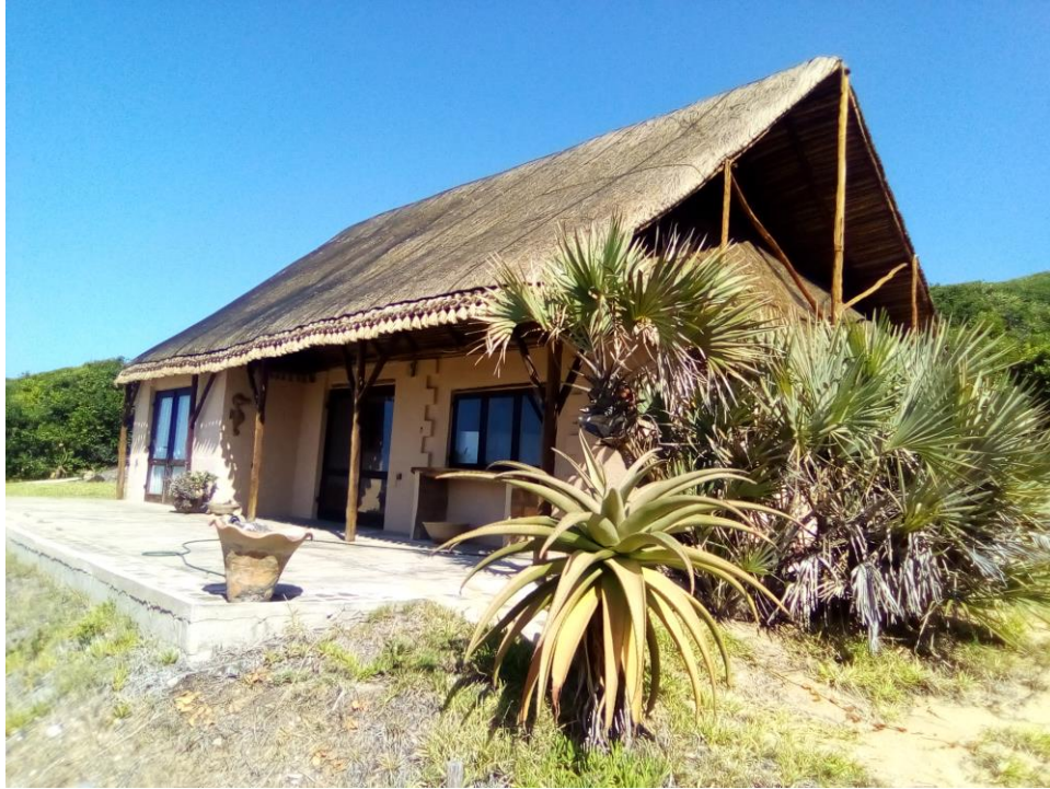
Foto 4: Vista parcial das infra-estruturas do projecto. Foto: KDSU (2022).
