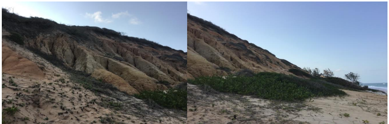
Figura 17. Erosão costeira vista na área do projecto, fonte Equipa de AIA
