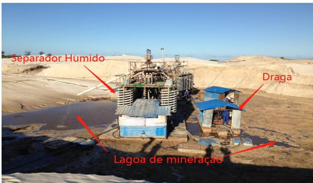
Figura 2. Draga de sucção usada para o processo de mineração, Fonte: Consultor Ambiental – 2019
