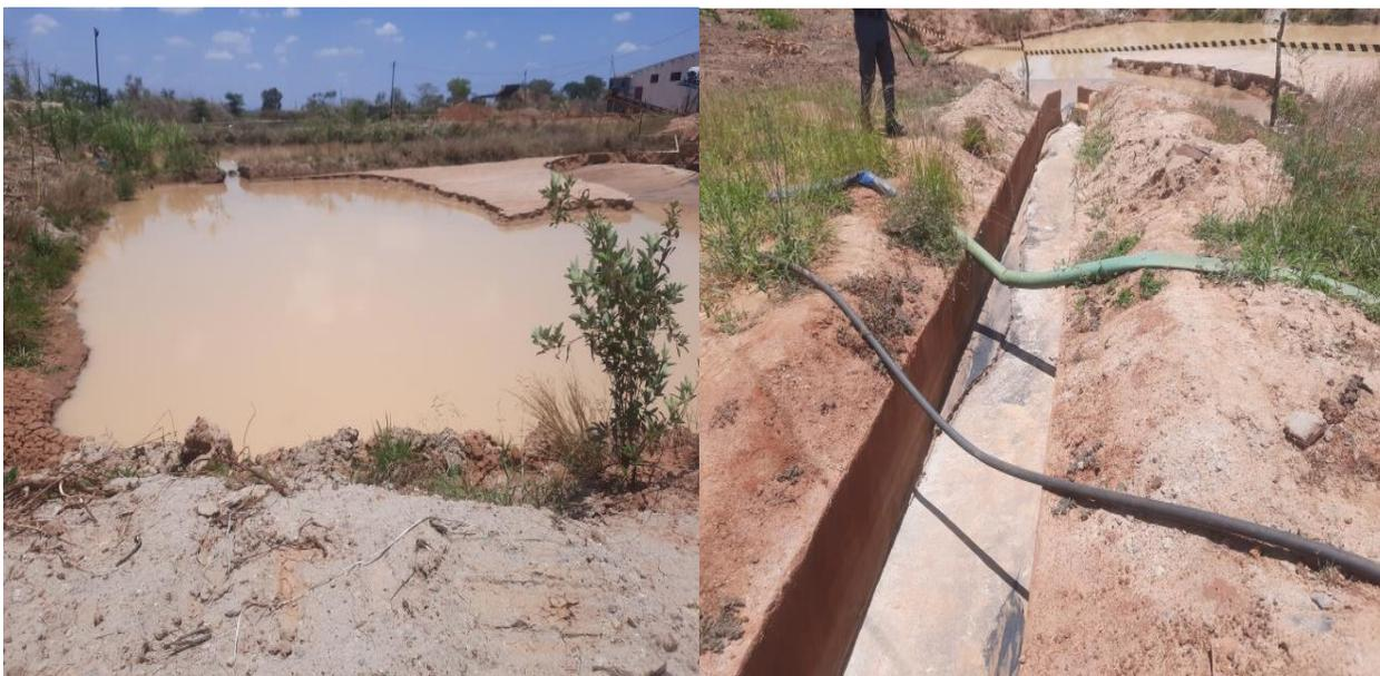
Foto 6: Ilustração de uma das bacias de decantação e canal de drenagem
