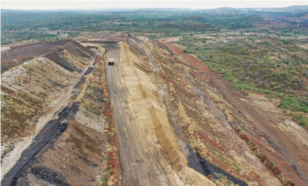
**Figura 4-2 Colocação de topsoil em taludes de pilhas de estéril (outra perspectiva)**
