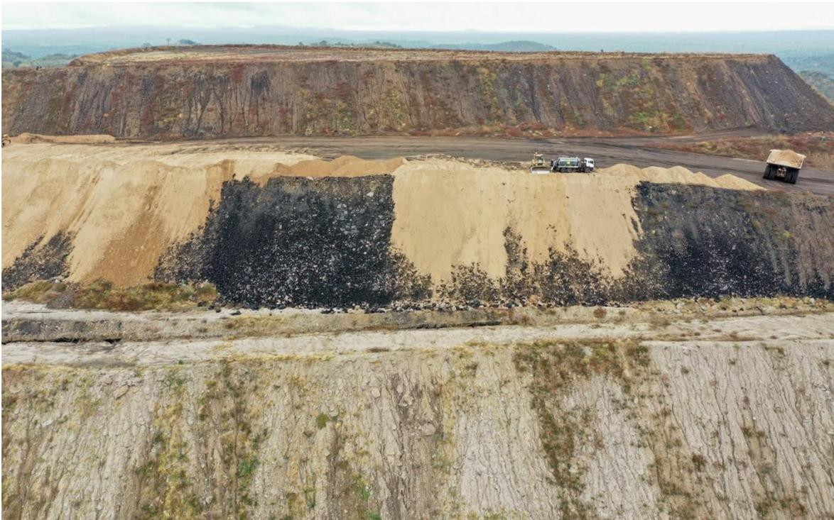
**Figura 4-1 Colocação de topsoil em taludes de pilhas de estéril**
