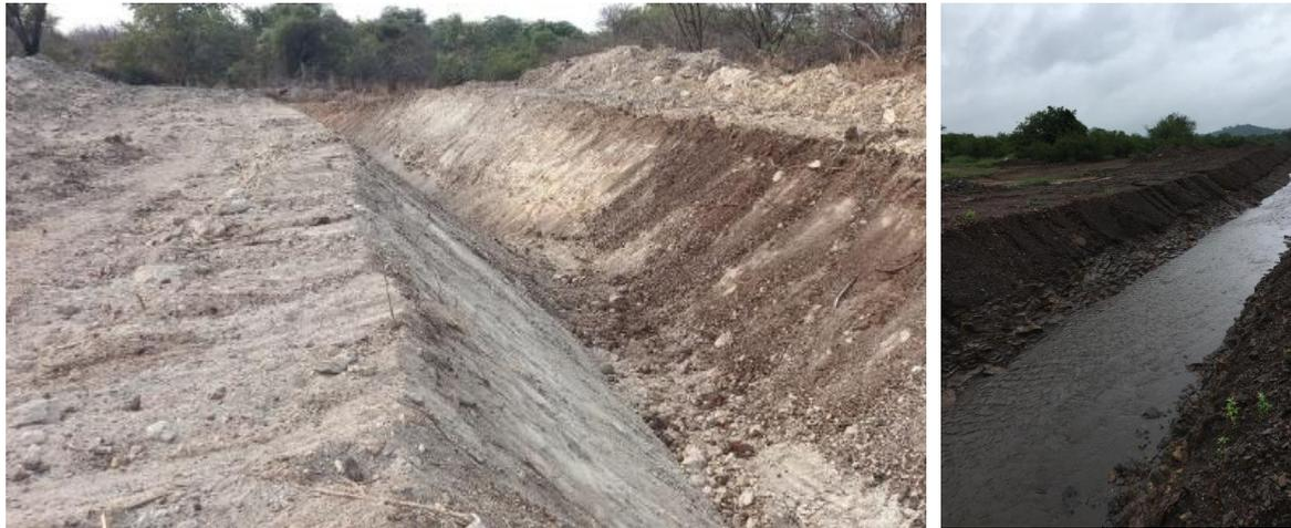
**Figura 6-16 Exemplo de um canal periférico escavado e com fluxo**
