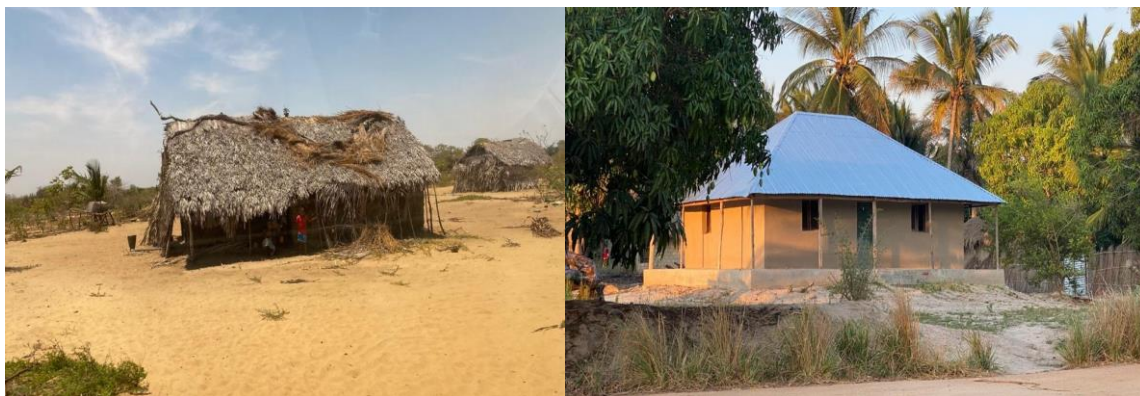
Fig.14. Habitação precária (esquerda) e habitação melhorada em Sacone (direita) (fonte: fotos do autor)
